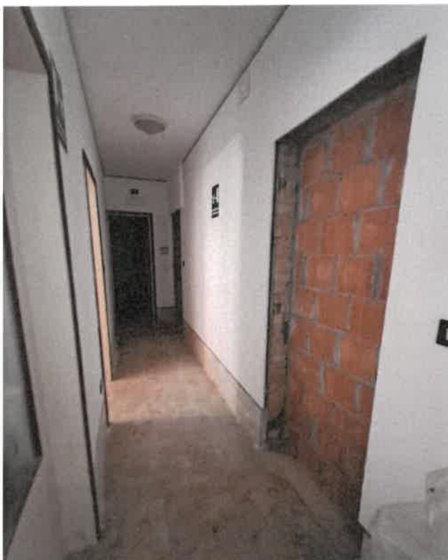
Corridoio piano terra
